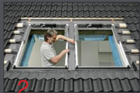
Die neue, patentierte Mittelrinne kann flexibel je nach Fensterabstand um maximal sechs Zentimeter bis an das rechte Fenster herangeschoben werden.
